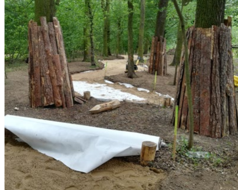
Fot. 23. Budowa żwirowego ciągu pieszo-rowerowego w Swojczyckim Parku Czarna Woda. Pomiędzy drzewami rosnącymi blisko siebie umiejscowiony będzie fragment chodnika rampowego (fot. Aleksandra Zienkiewicz)
