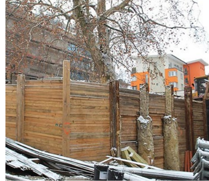
Fot. 6. Grudzień 2012 / styczeń 2013 – głębokie wykopy poza zakresem rzutu korony przy użyciu technologii zabezpieczenia wykopu ścianką szczelną (fot. Dominika Krop-Andrzejczuk)
